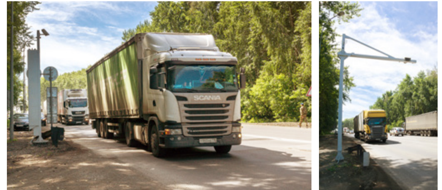
Автоматизированный пункт весового и габаритного контроля, г. Кемерово (въезд со стороны г. Ленинска-Кузнецкого)
