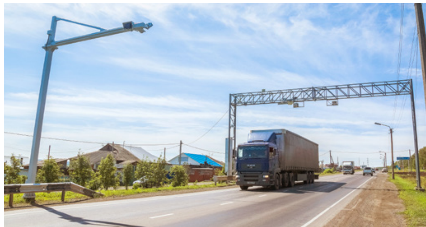
Автоматизированный пункт весового и габаритного контроля, г. Кемерово (въезд со стороны пгт Промышленная)
