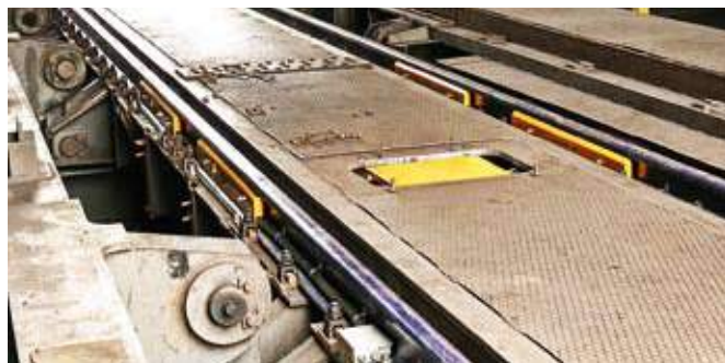
Вагонные весы «РТВ-С», встроенные в вагонопрокидыватель
